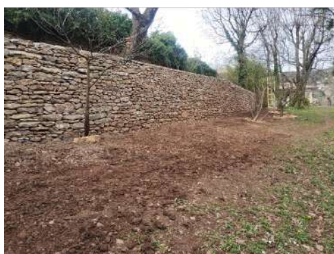
Mur en pierres sèches - Saint Didier au Mont d'Or
