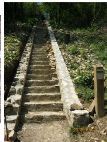
Restauration escaliers - Curris au Mont d'Or
