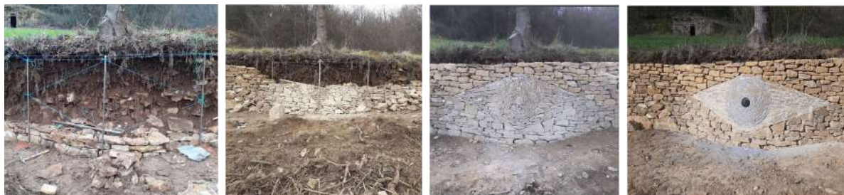
Mur en pierres sèches - Curris au Mont d'Or
